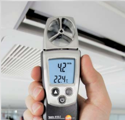
Измерения скорости потока воздуха на вентиляционных выходах с помощью 40 мм крыльчатки
