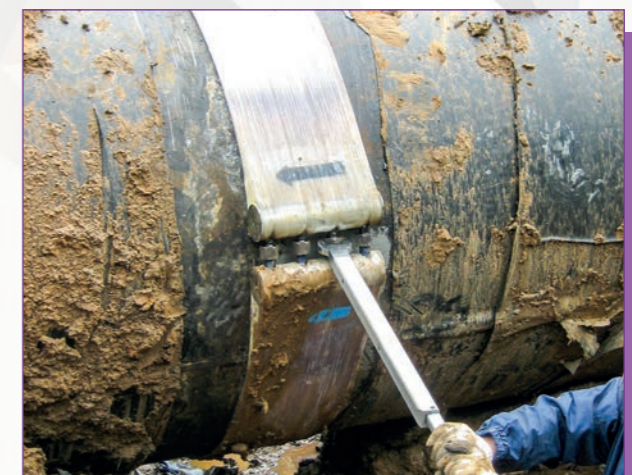
Создание контактного давления при помощи динамометрического ключа
