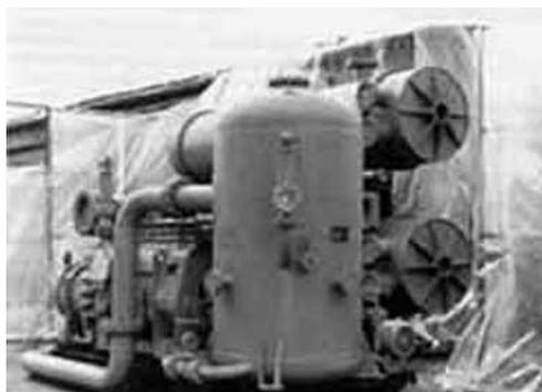
**Рис.3. Общий вид теплового насоса мощностью 1МВт, устанавливаемого в котельной**
