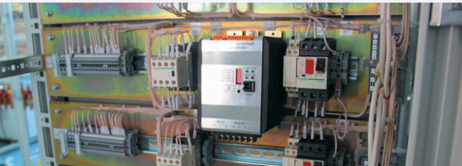
Пускатель бесконтактный реверсивный интеллектуальный ПБР-И в составе шкафа управления
